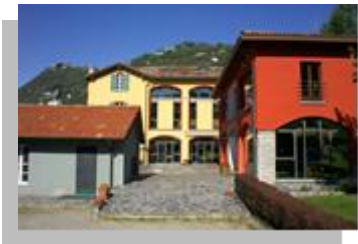
Monte Verde 2 via Strada Statale per Lecco,4 – Como
